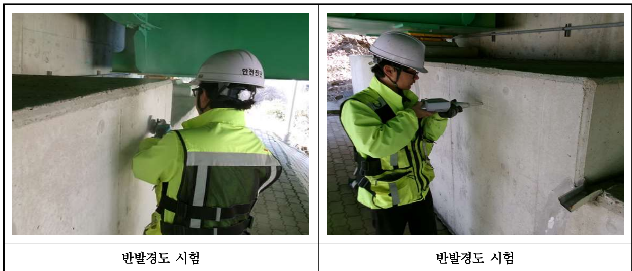
【사진 4.4.2】 반발경도시험 현장사진
