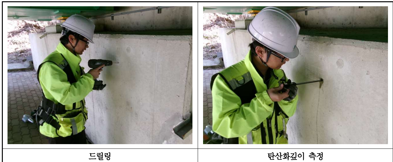
【사진 4.4.3】 탄산화 깊이 측정 현장사진
