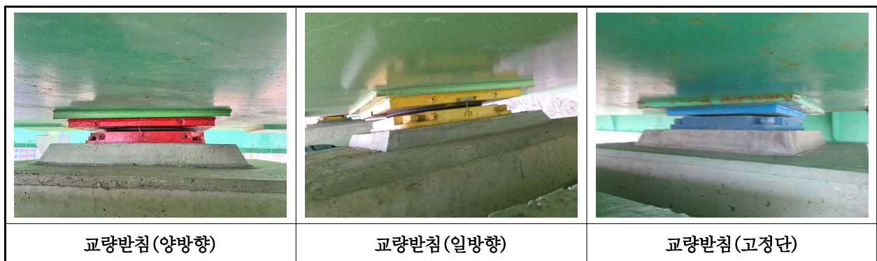
【사진 4.3.13】 교량받침 전경
