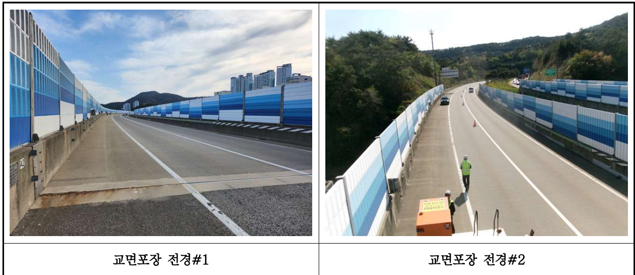
【사진 4.3.20】 교면포장 전경
