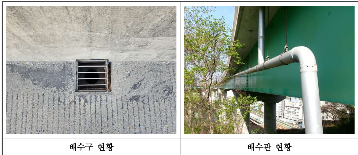
【사진 4.3.22】 배수시설 전경
