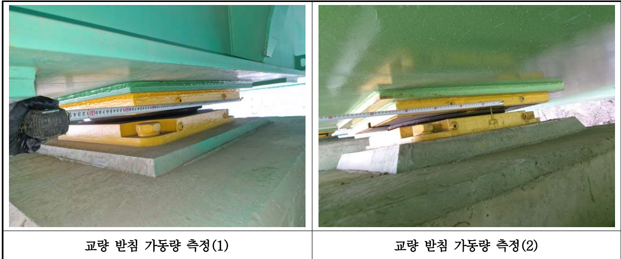
【사진 4.3.16】 교량받침 이동량 측정
