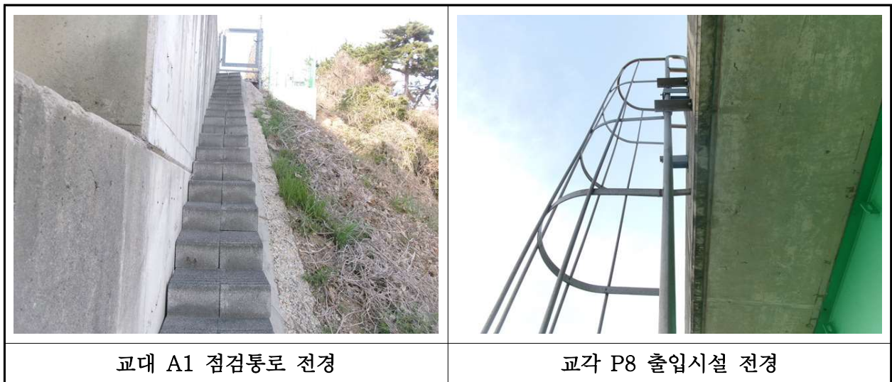
【사진 4.3.26】 교량 점검시설 전경
