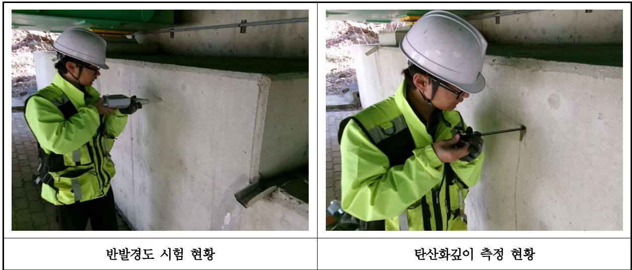
【사진 4.4.1】 콘크리트 내구성조사 현황
