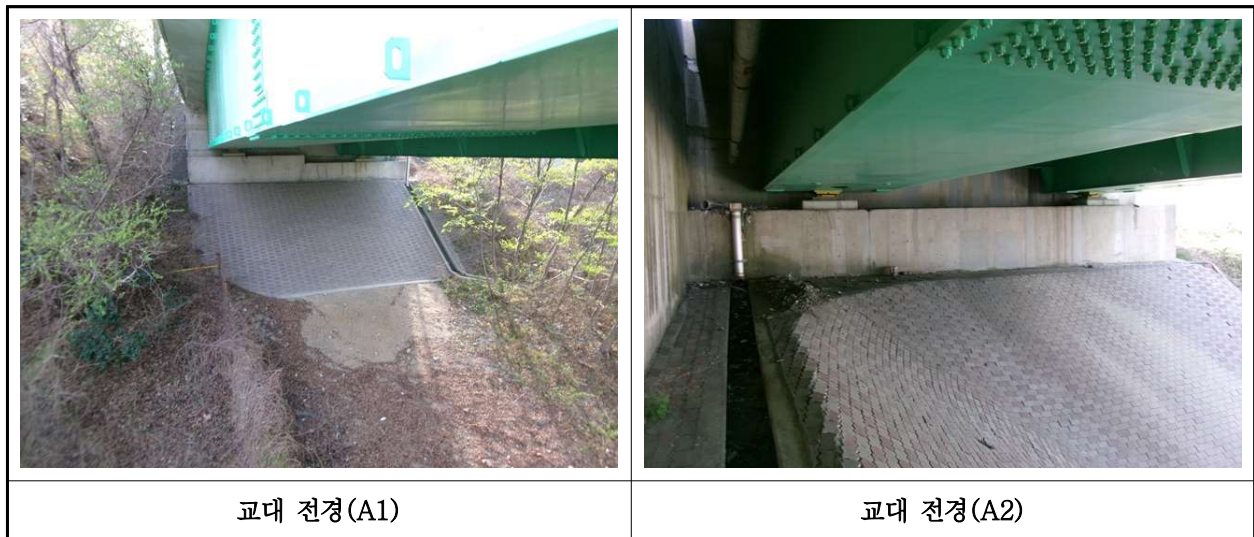
【사진 4.3.8】 교대 전경
