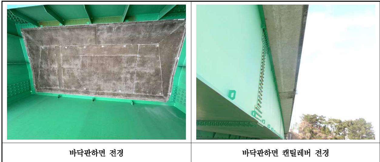
【사진 4.3.2】 바닥판하면 전경
