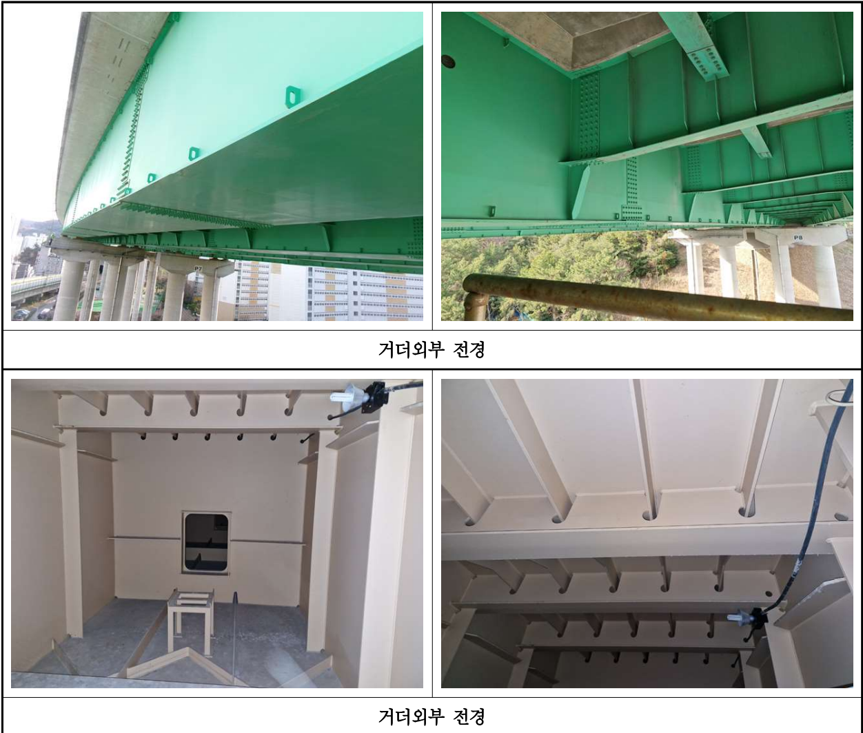
【사진 4.3.4】 거더 전경
